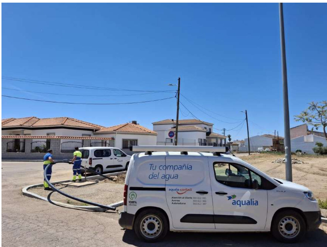
Obras en Quintana de la Serena por la renovación de la red de abastecimiento.
