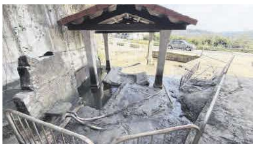
Lavadero de A Regueira lleno de lodo.
