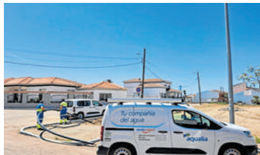
Operarios trabajando en Quintana. hoy
