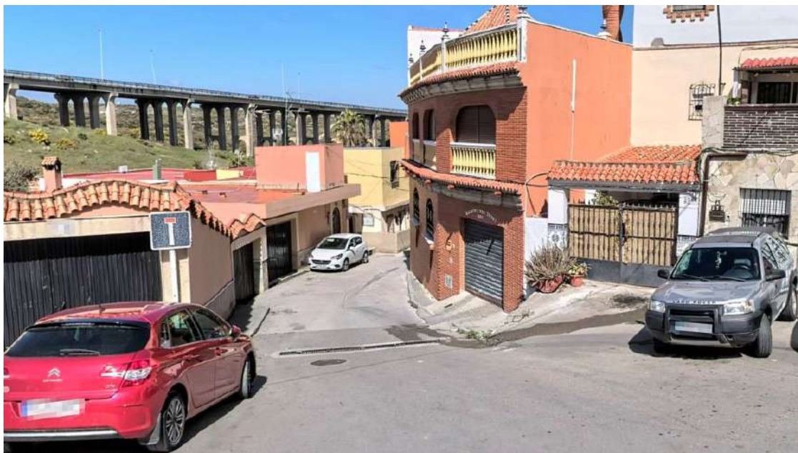
La rotura de una tubería deja sin agua a varias zonas de Algeciras
