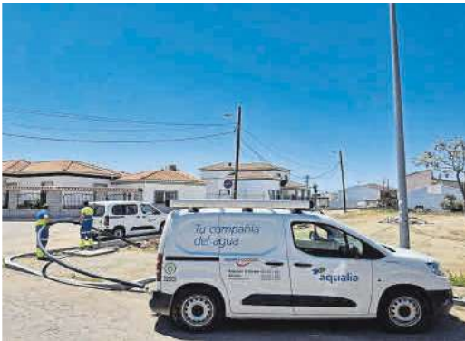
Obras en las infraestructuras hidráulicas de Quintana de la Serena.
