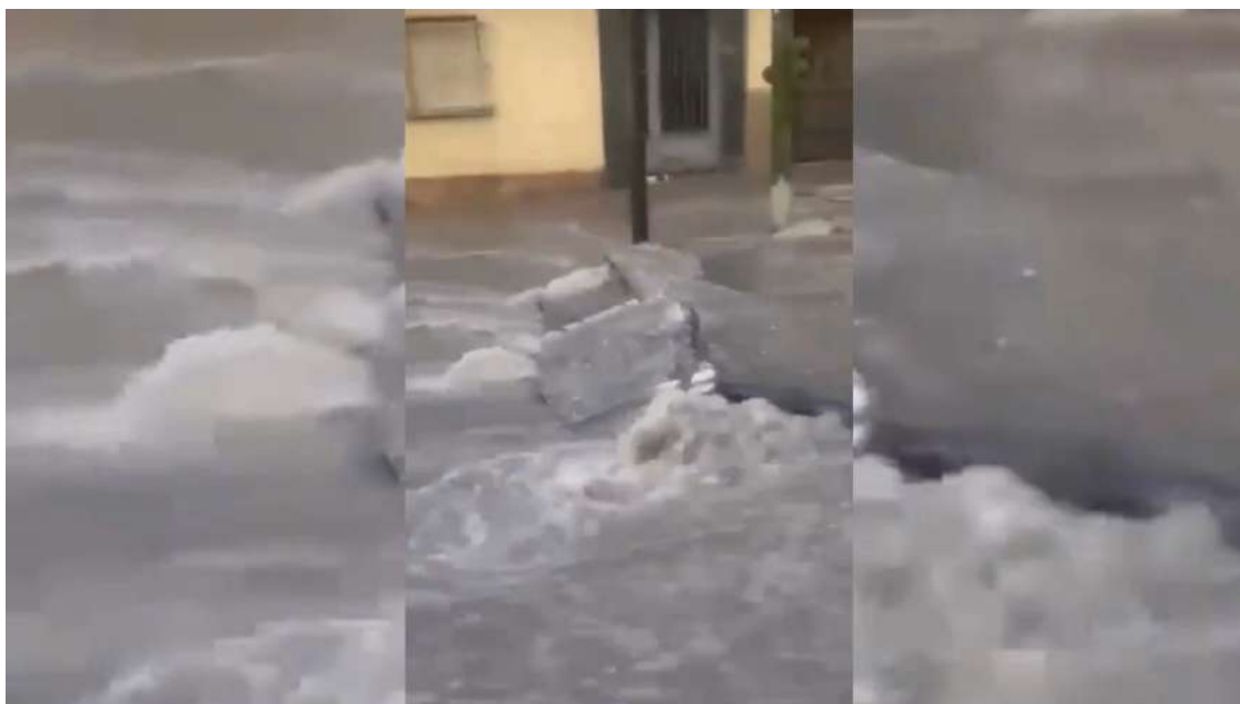
Graves daños en la avenida Arjona de Jaén a causa de la tromba de agua
